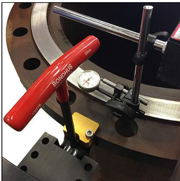
FIGURE 3-7. INDICATEUR À AIGUILLE INSTALLÉ POUR LE NIVELLEMENT
